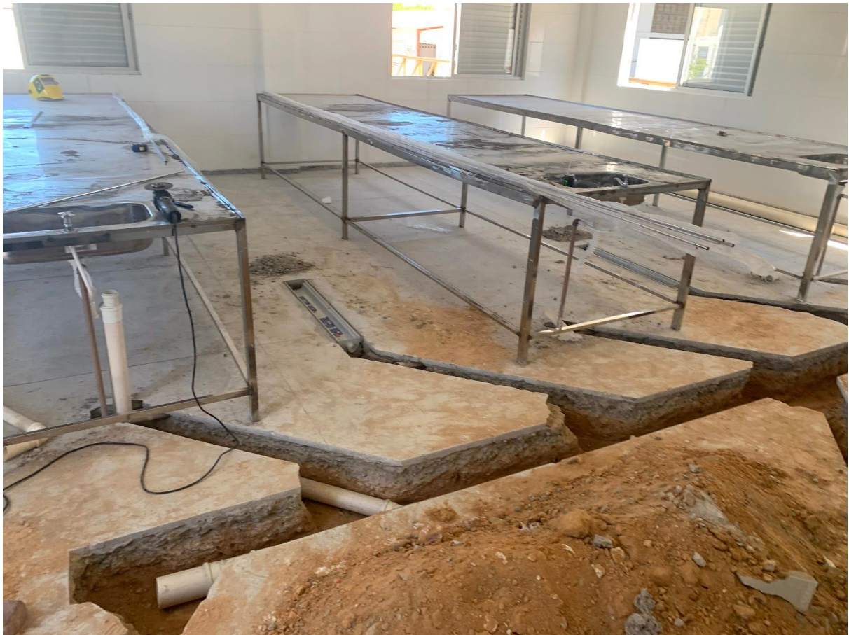
drenagem e esgotamento das salas de filetagem e dos box para guarda de caixas térmicas e freezer com pescados.
