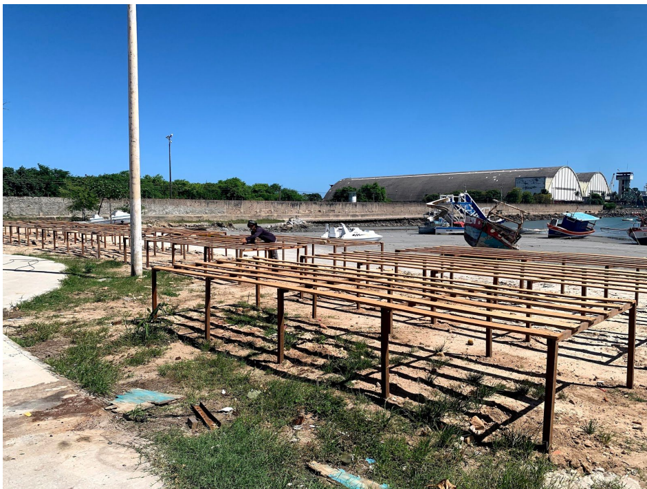
Secagem de pescados, sem esgotamento ou higiene, perfurando solo em locais proibidos, tubulação da Petrobrás;
